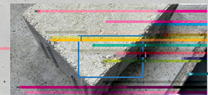
Fehlermarkierung blau: Ausbruch
